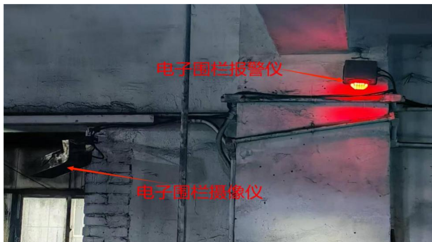
204 带式输送机头电子围栏（图 1-9）
