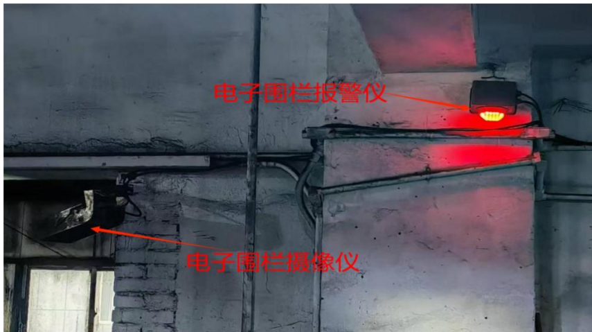
204 带式输送机头电子围栏（图 1-9）
