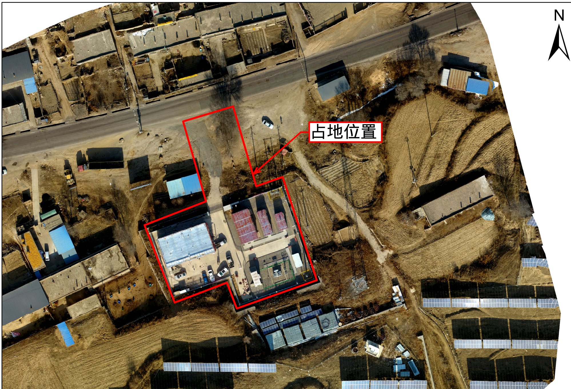
中阳县20MW集中式光伏扶贫电站项目位置影像图
